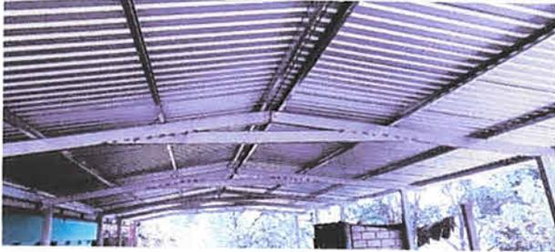
Foto 1: Cambio de Estructura metalica porque se encontraba en mal estado
