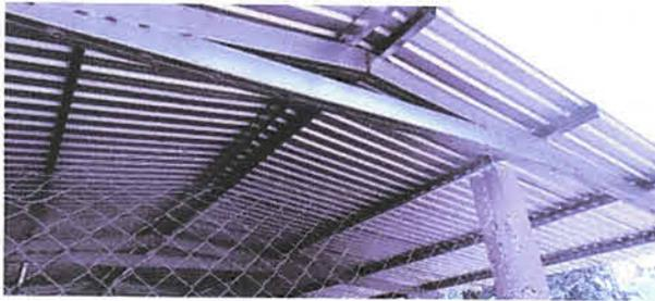
Foto 3: Cambio de Estructura metalica porque se encontraba en mal estado
