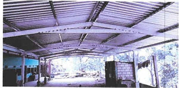
Foto 4: Cambio de Estructura metalica porque se encontraba en mal estado
