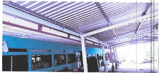
Foto 2: Cambio de Estructura metalica porque se encontraba en mal estado
